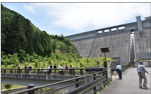
ダム見学(大山ダム)
