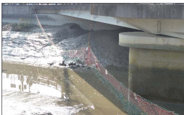
葦の葉流出防止網設置
