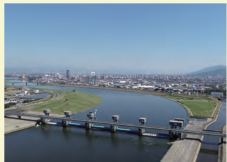
筑後大堰(水資源機構筑後川局 提供)
