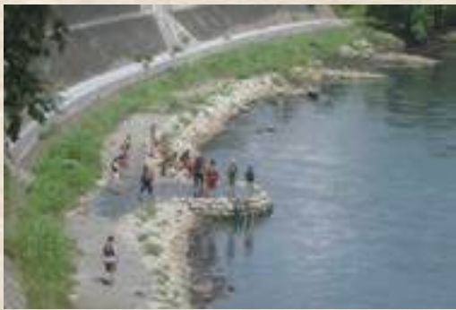
水辺の利用にも配慮した低水水制を用いた護岸（白川）
