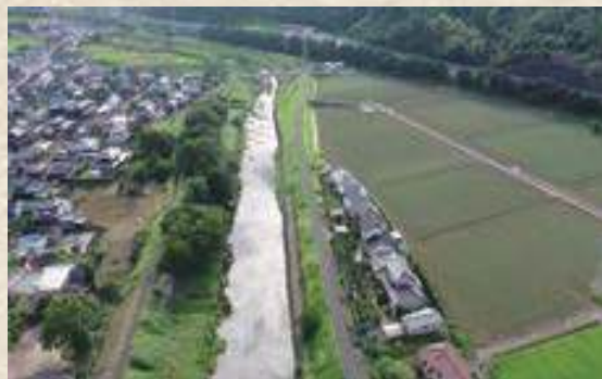
堤防の線形を湾曲させて保全した棕の樹林帯（牛津川）
